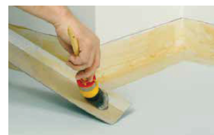
Boden und Wand bis zur Markierung mit Kontaktklebstoff einstreichen.
