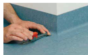
Überstehenden Belagsstreifen abschneiden. Dann abdichten mit Schmelzdraht/Schweißschnur.
