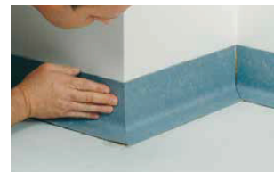
Zugesägte HSLA Leiste befestigen.
