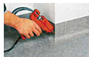
Abdichten mit Schmelzkleberpistole oder mit farblich passender Dichtungsmasse.
