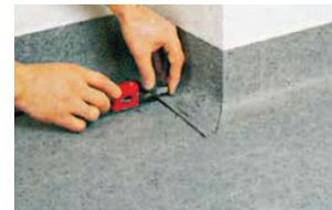
Abschneiden des überstehenden Belagsstreifens.
