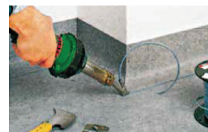
Abdichten mit Schmelzdraht /Schweißschnur
