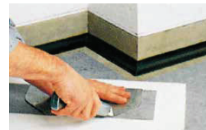
Gehungsschnitt mit Schablone.
